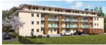
Schierling I Im Bau Barrierefreies Wohnen
