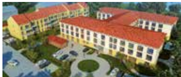
Baar-Ebenhausen Im Bau Seniorenwohn- und Pflegeeinrichtung / Seniorengerechtes Wohnen
