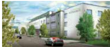
Durmersheim Baubeginn in Kürze Seniorenwohn- und Pflegeeinrichtung / Seniorenrechtliches Wohnen
