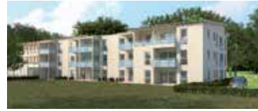
Schierling II Im Bau Barrierefreies Wohnen
