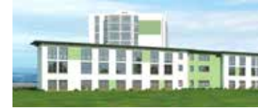
Deggendorf Im Bau Seniorenwohn- und Pflegeeinrichtung / Seniorengerechtes Wohnen
