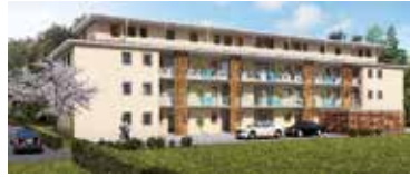
Schierling I Im Bau Barrierefreies Wohnen
