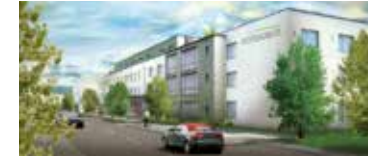
Durmersheim Baubeginn in Kürze Seniorenwohn- und Pflegeeinrichtung / Seniorengerechtes Wohnen
