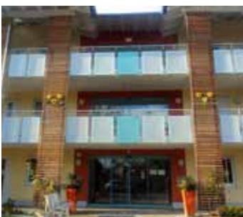
Seniengerechtes Wohnen 83536 Gars am Inn Augustinerstraße 15
